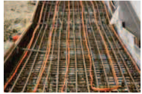
Ukázka položení topného kabelu EM2-XR do nájezdové rampy (RAYCHEM)
