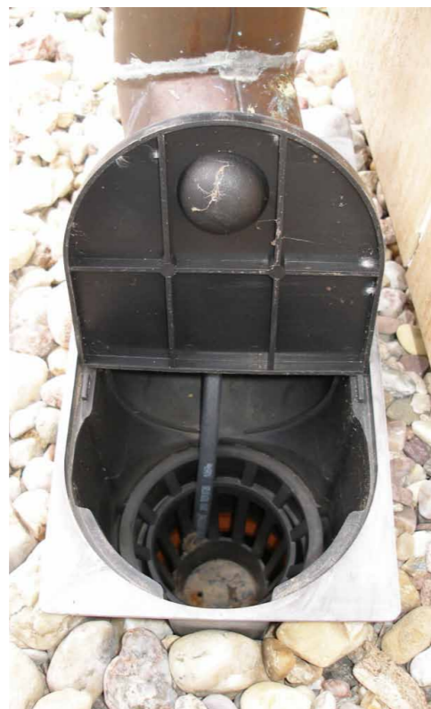
Aplikace topného kabelu FroStop (RAYCHEM)
