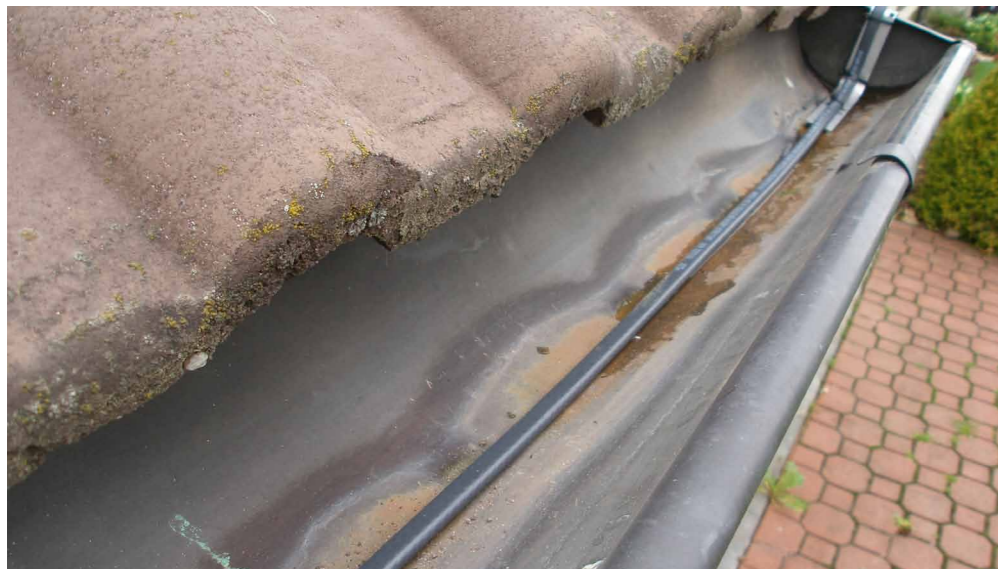
Samoregulační topný kabel FroStop Black pro ochranu žlabů a svodů před zamrznutím se vyznačuje úsporou nákladů, minimální fixací a snadnou instalací (RAYCHEM)
