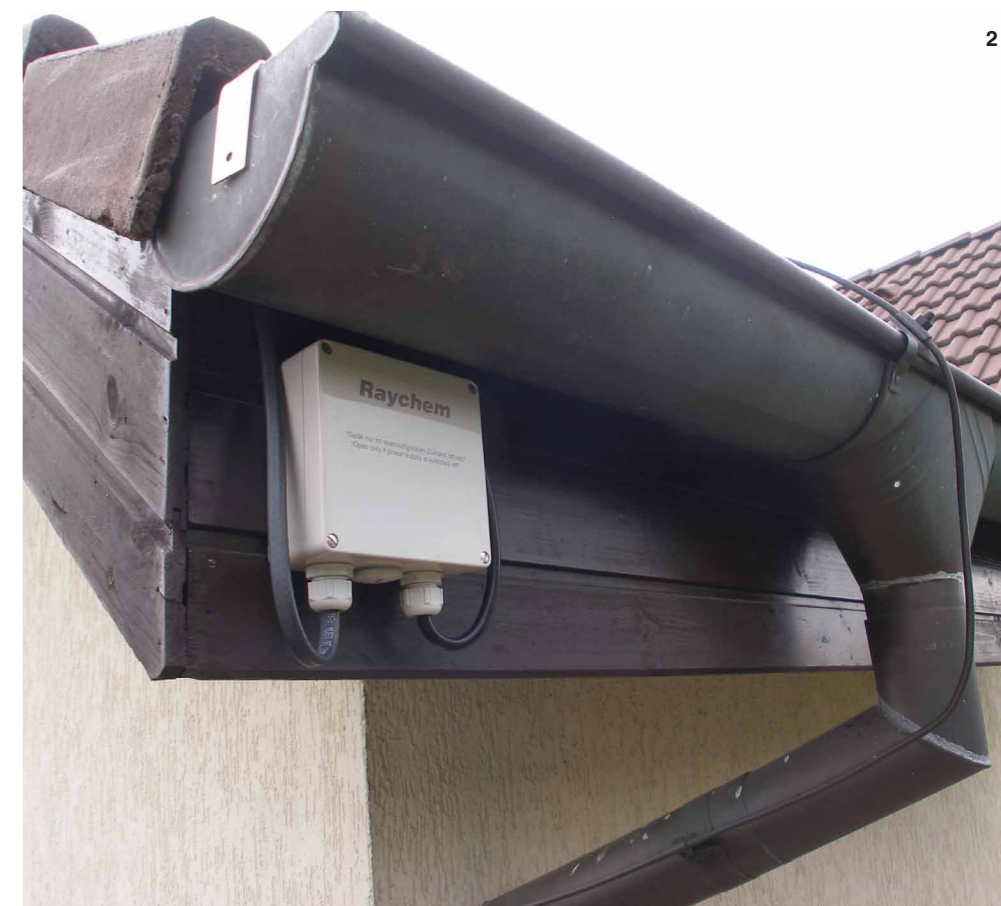
2 HTS-D-Thrmostat je řídicí jednotka pro okapy s 2 nezávislými spínacími body, pro úsporný provoz u topných systémů do celkové délky 30m (RAYCHEM)
